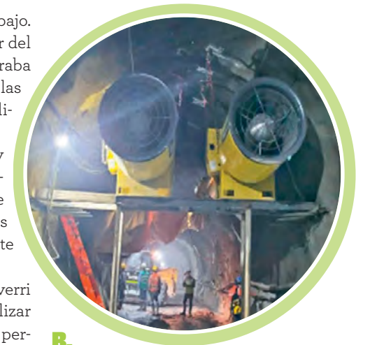
B. Ventiladores ubicados en la penúltima conexión del túnel y la galería de rescate.
