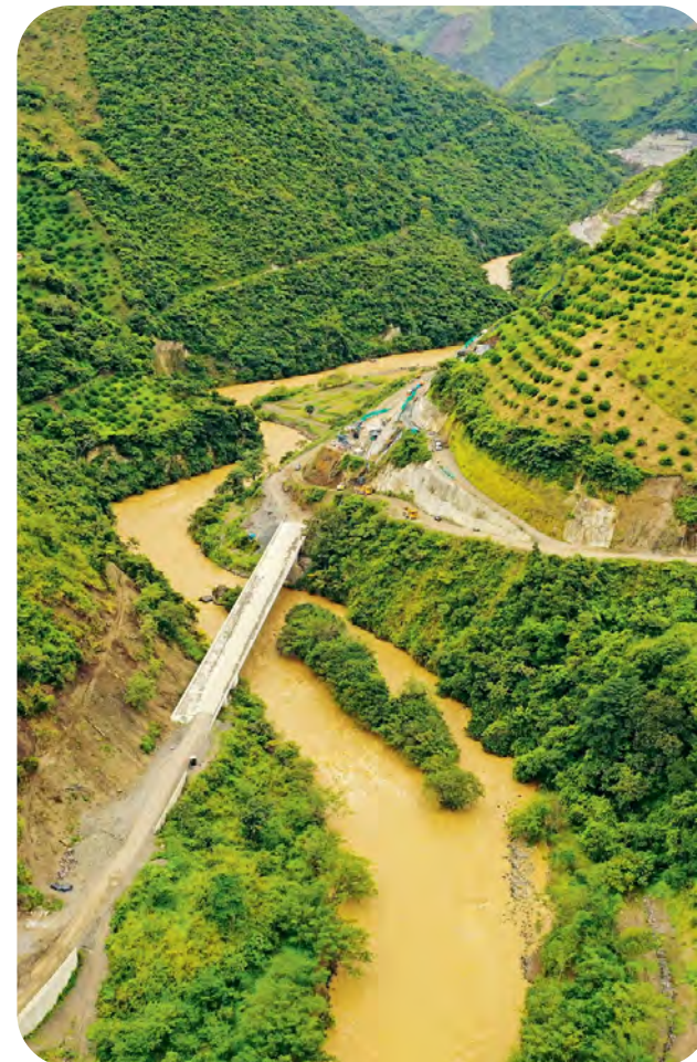
La construcción de las distintas obras avanza de manera simultánea.
