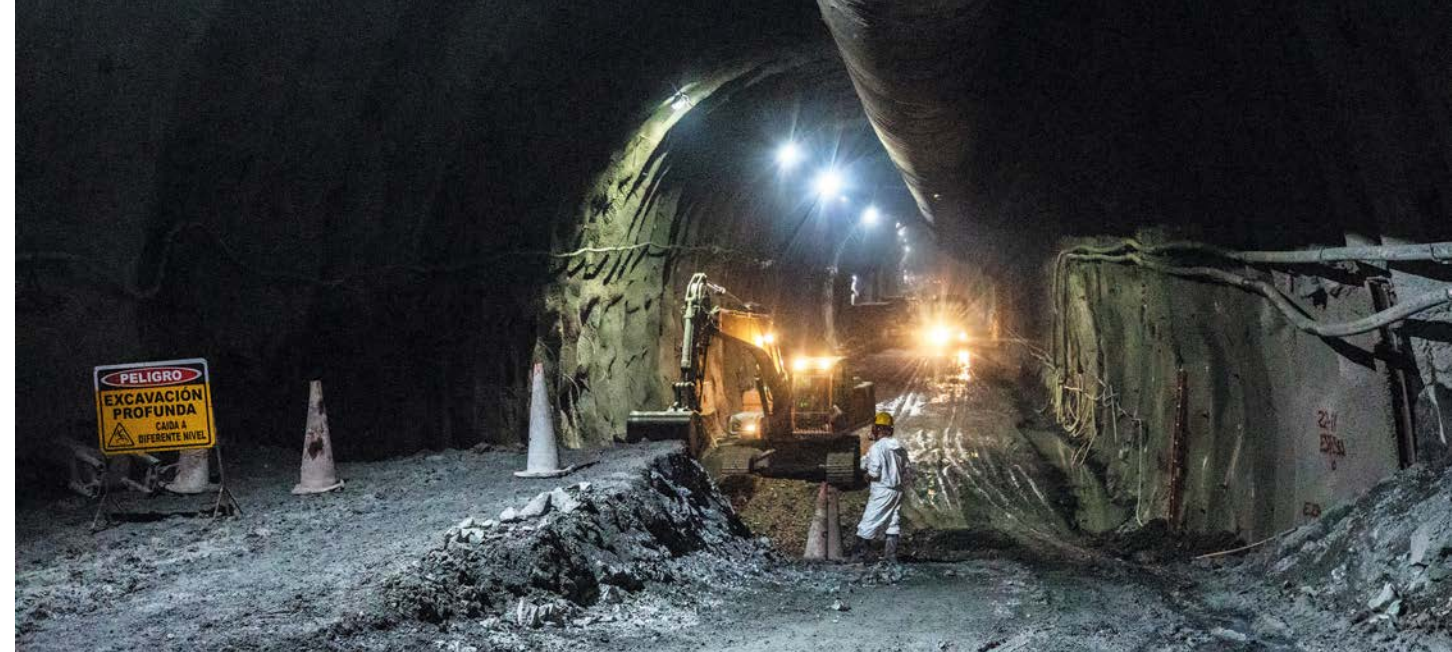
El túnel GGE constituye un hito en la ingeniería.
